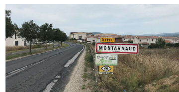
Entrée de ville Sud, en cours de construction Source : Verdi, 2022
